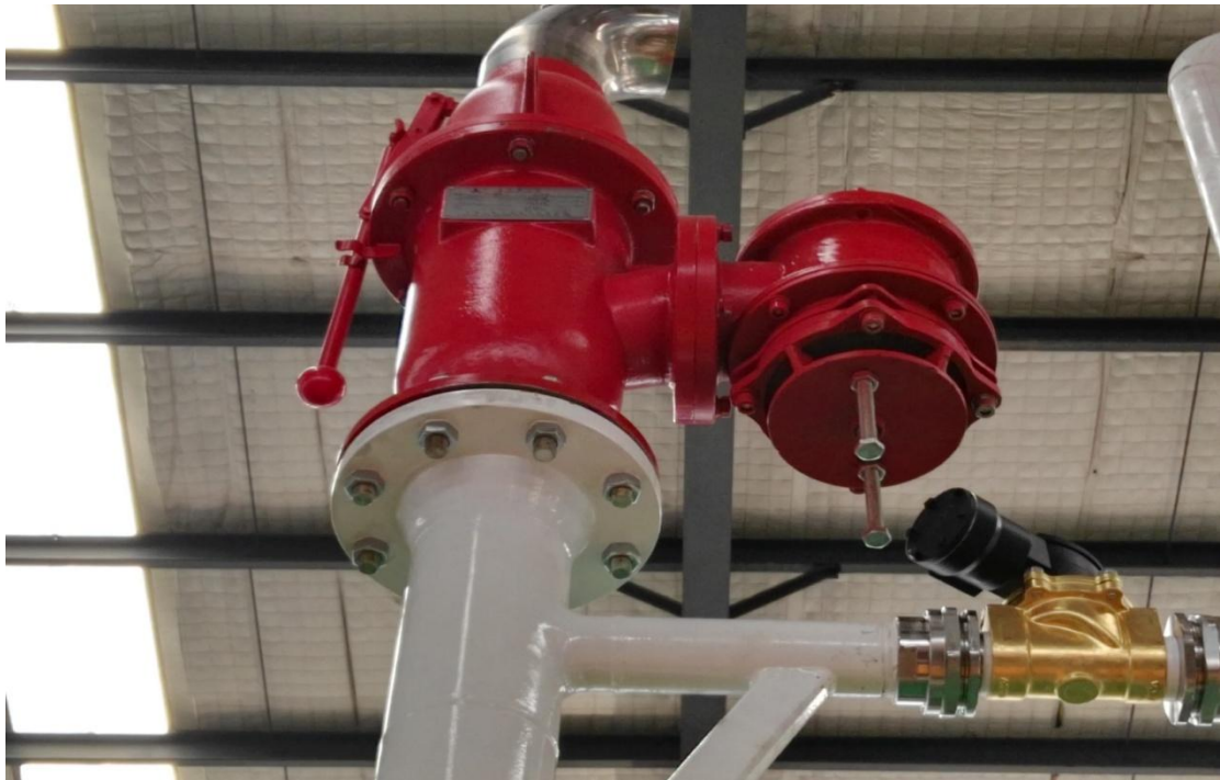
图 3-7 压力/真空释放阀
