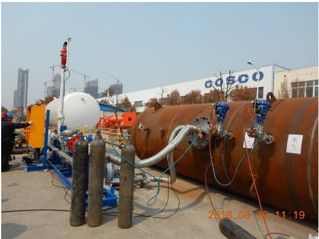
图 3-1 样机试验平台
