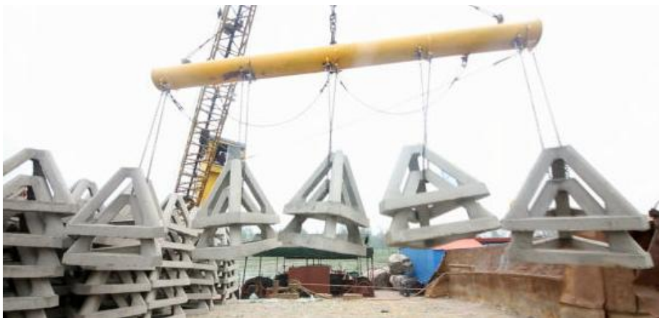
图 3.2-1 整体式四面六边透水框架机械成组抛投
