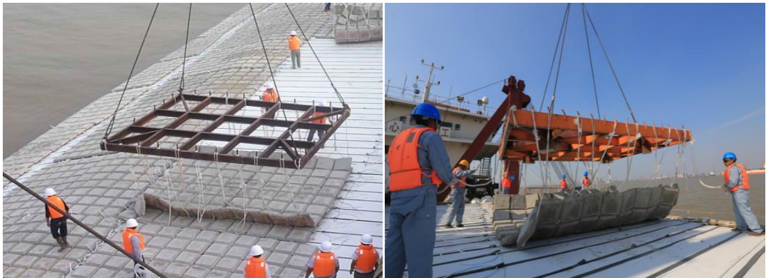
图 3.1-5 混凝土连锁片吊放
