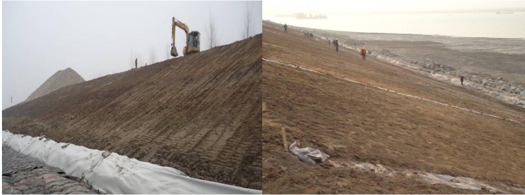
图 4.1-1 岸坡机械开挖
