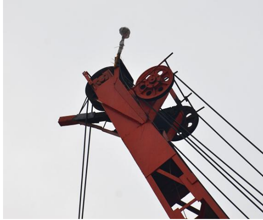
图 3.2-4 浮吊臂顶部安装 GNSS
