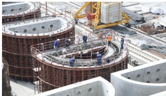
图 2.3-6 混凝土浇筑
