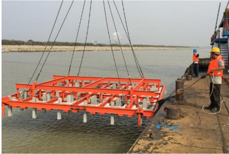
图 3.2-2 双工字型透水框架机械成组抛投
