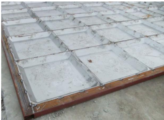
图 2.1-4 模板安装示意图
