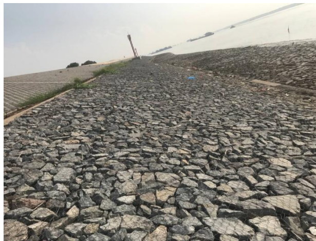
图 4.3-1 钢丝网护面
