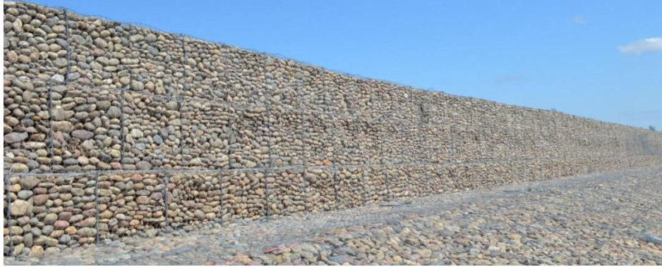
图 4.5-1 钢丝石笼挡墙
