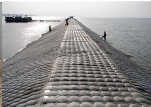
图 5.1-5 模袋混凝土坝面
