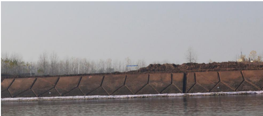
图 4.2-4 盲沟开挖后远景
