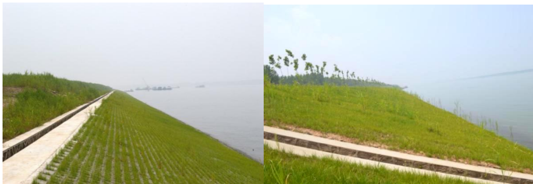
图 4.4-1 生态工程实施后效果图（左为钢丝网生态护坡，右为连锁块生态护坡）
