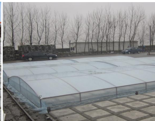
图 2.1-10 薄膜罩养护
