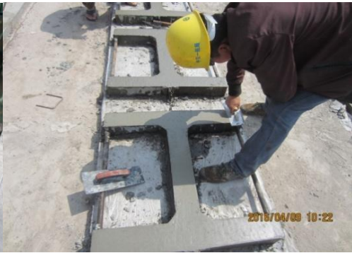
图 2.2-8 混凝土收面
