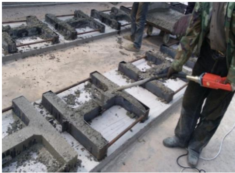
图 2.2-7 混凝土振捣
