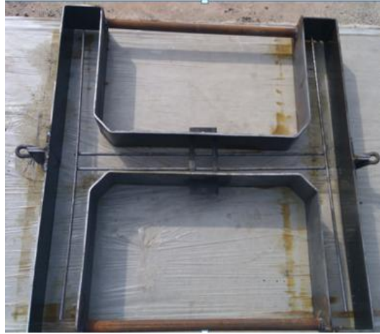
图 2.2-6 组装完成的模板
