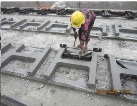
图 2.2-9 透水框架拆模
