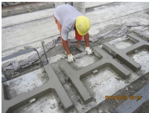
图 2.2-9 透水框架拆模
