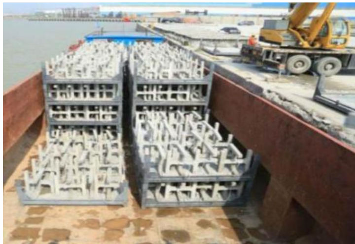
图 2.2-11 双工字型透水框架深舱驳出运
