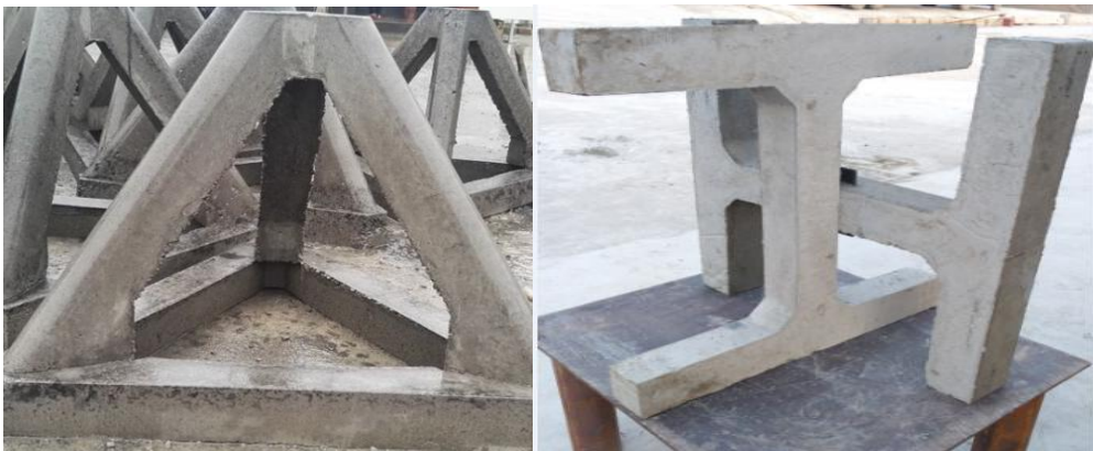
图 2.2-1 整体式四面六边透水框架图
