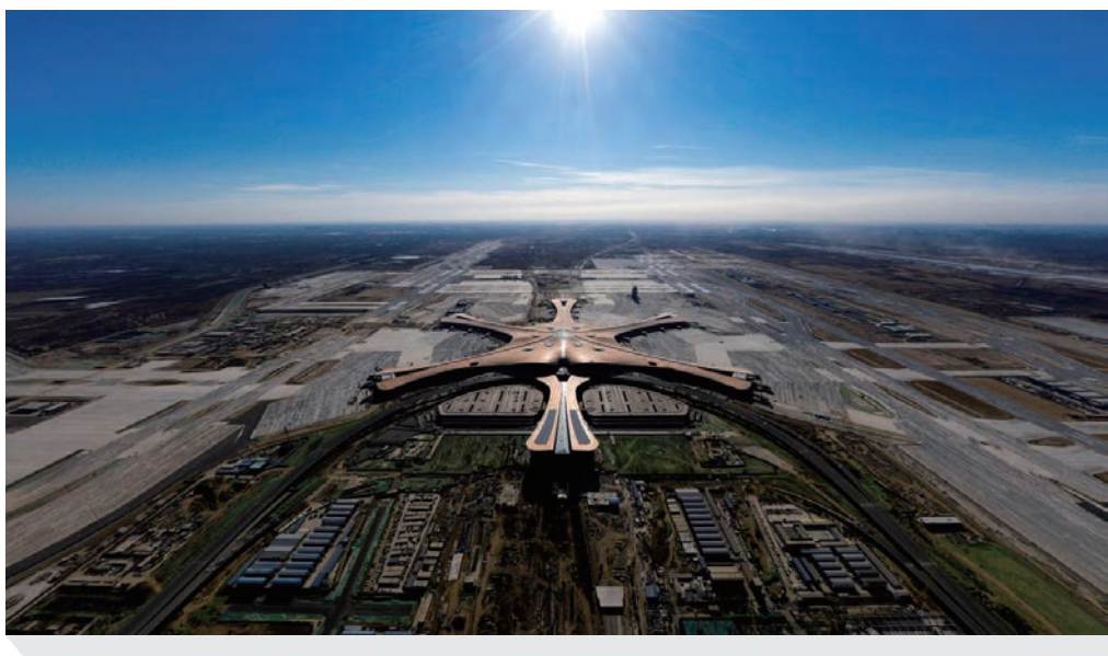
图 北京大兴国际机场
