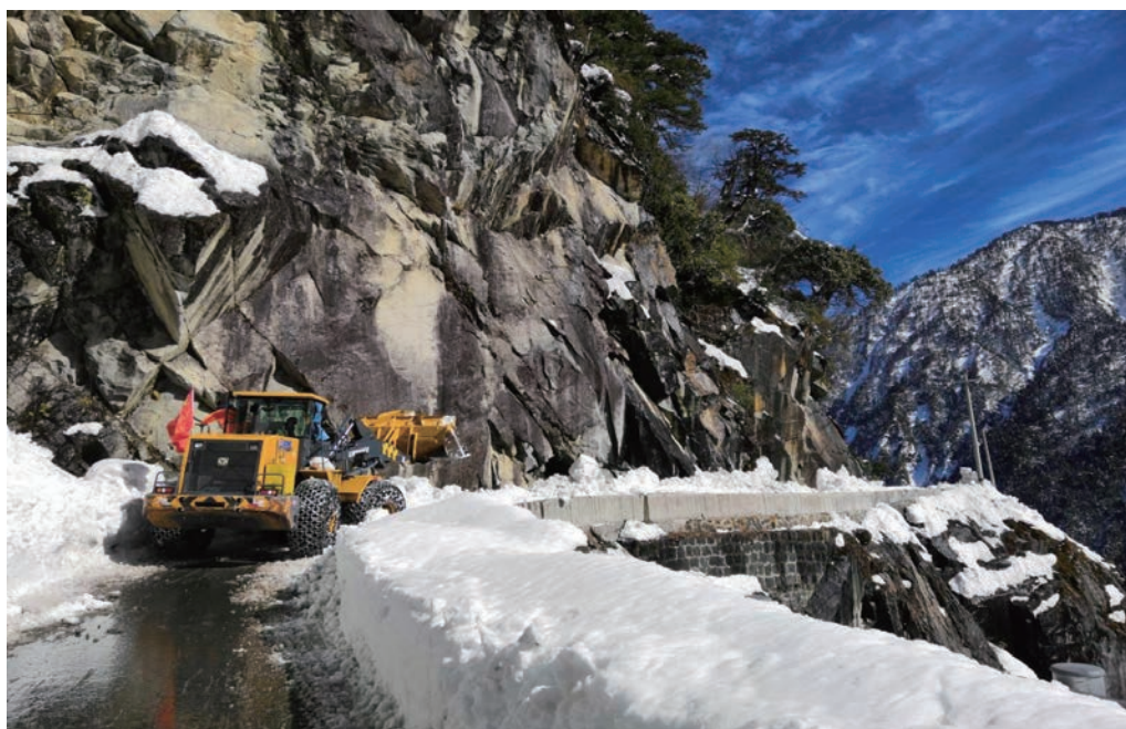
图 实施公路抢通作业
