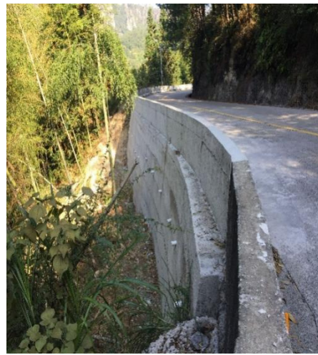
图 6 临石线 K109+200 (修复后)
