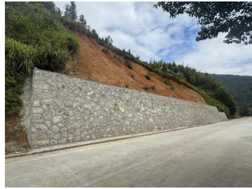
图 6 X411 蓬源线 K0+600 修复后
