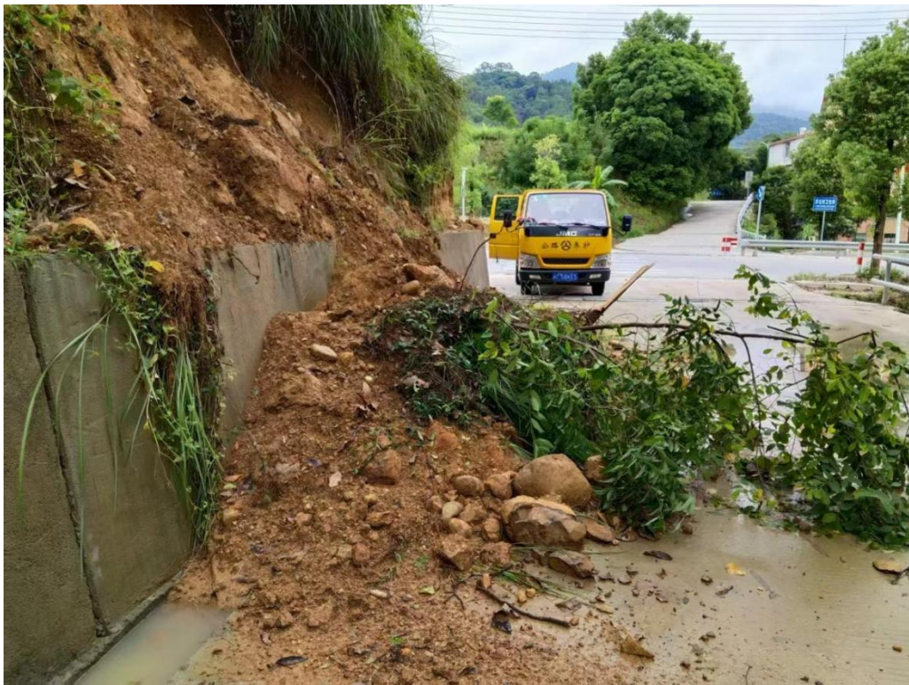
图 5 道路堵塞及时疏通
