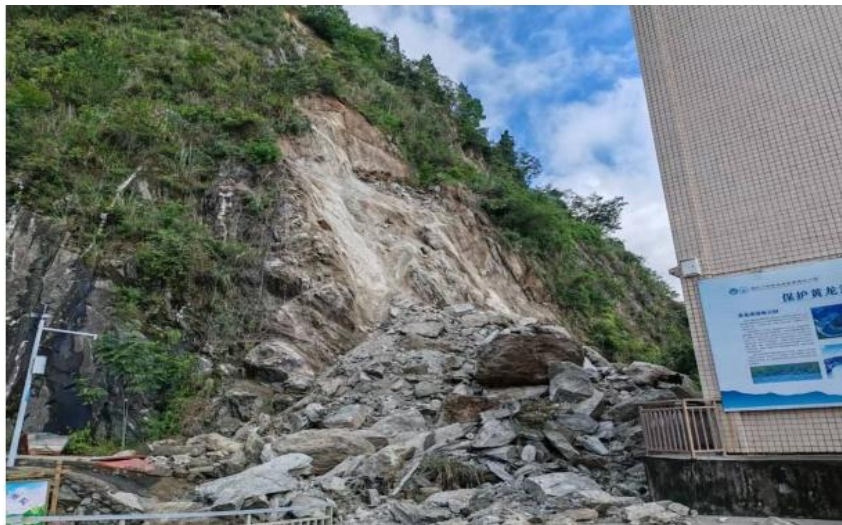
图1 黄龙滩水库码头山体滑坡灾情全貌
