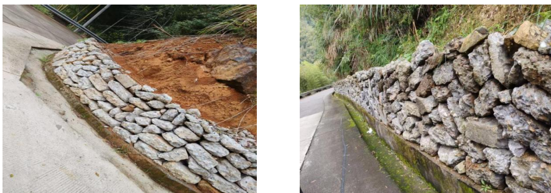
图 5 小口至五凤垟村道破板利用后
