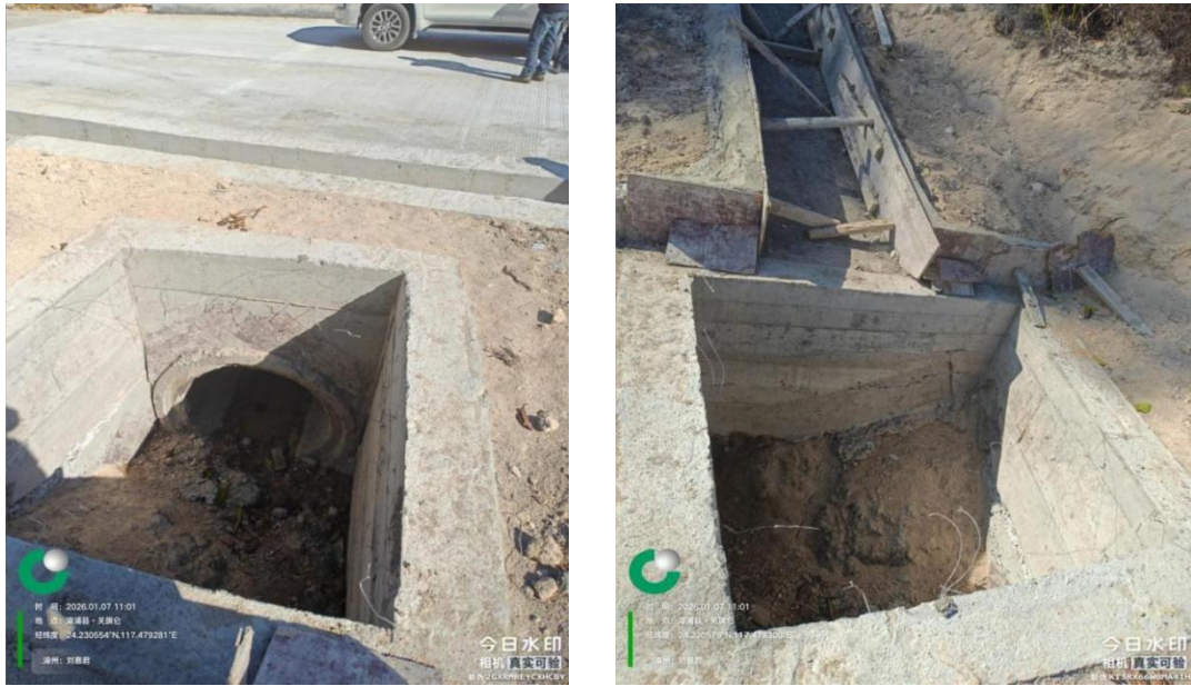
图 4 漳浦县车本村象车线 K14+954 增设急流槽和涵洞情况
