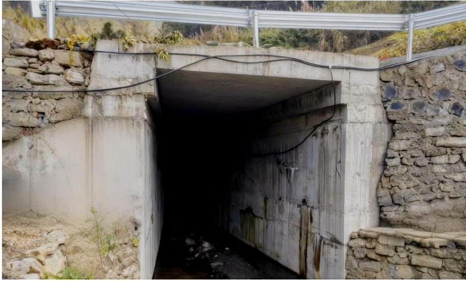
图 2 C905 聂二线涵洞施工后
