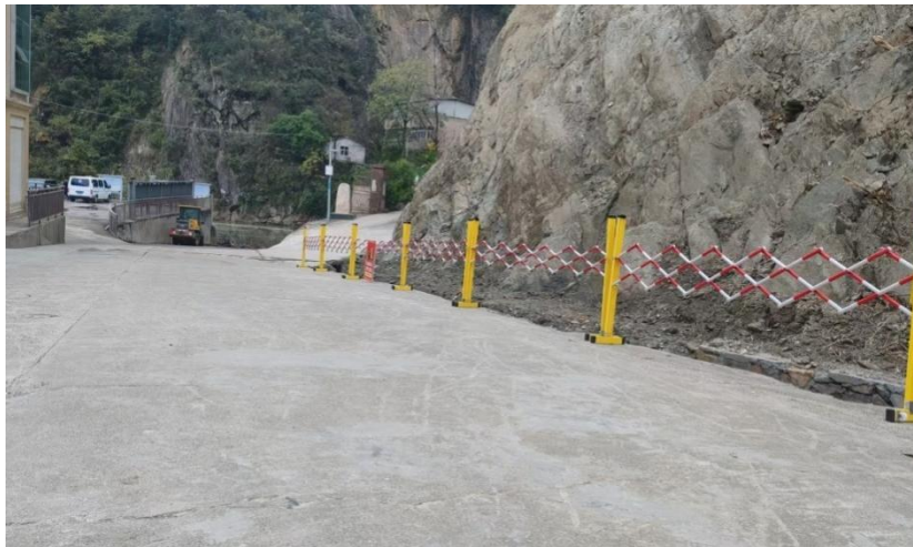
图3 道路恢复畅通保障库区清理工作正常开展
