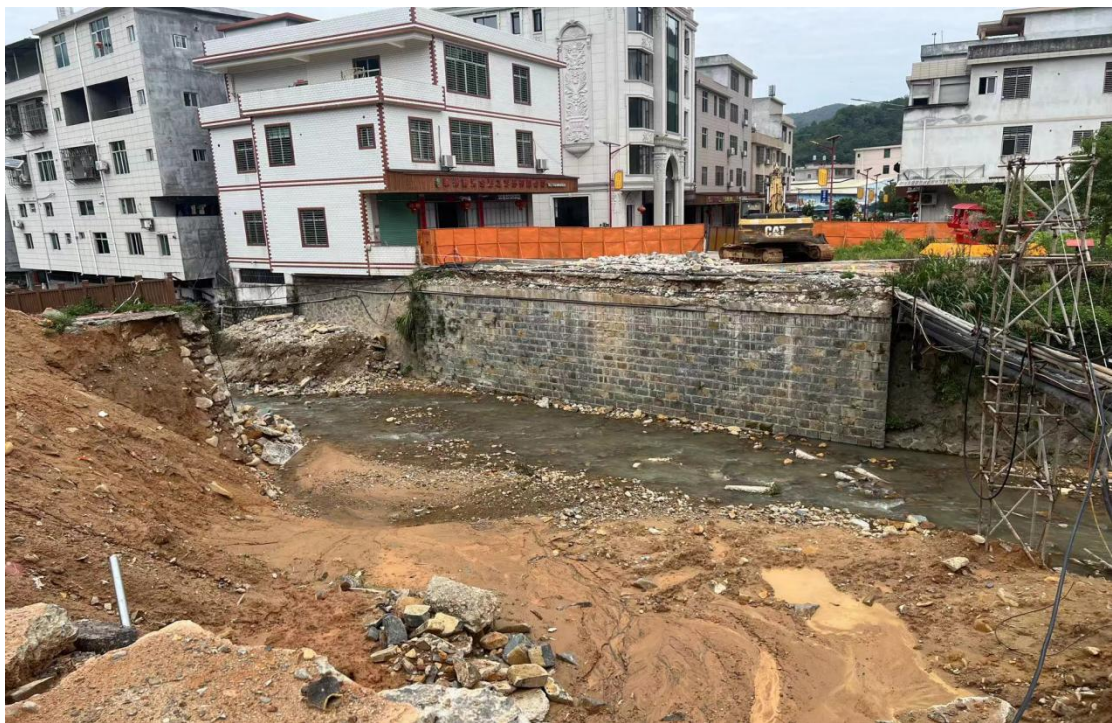
图 3 安溪县尚卿乡灶美村灶美小桥危桥拆除
