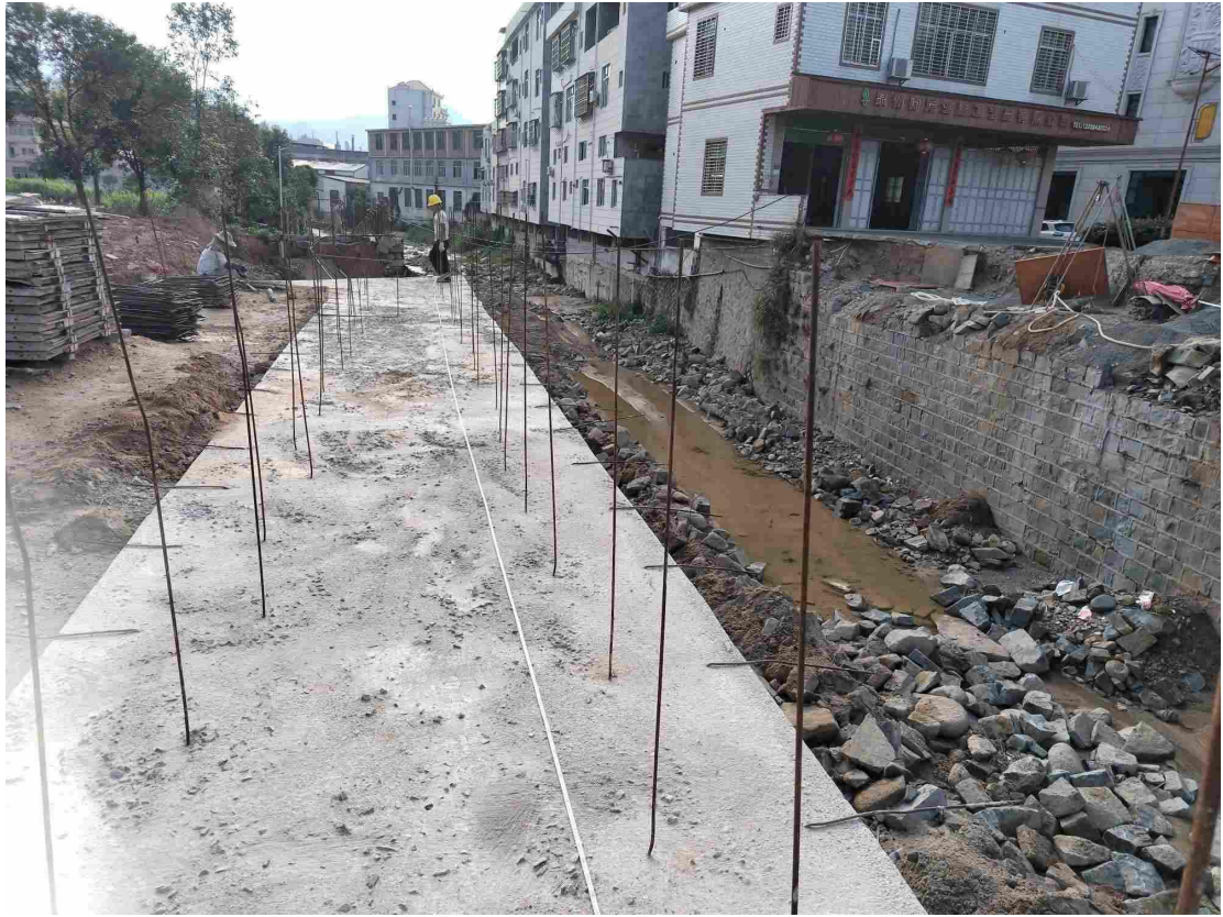
图 4 安溪县尚卿乡灶美村灶美小桥重建
