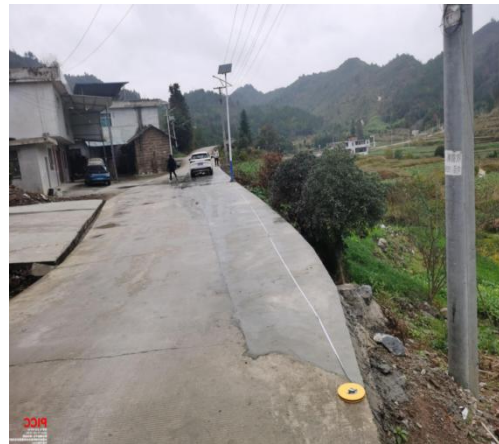
图 10 小型病害快速修复
