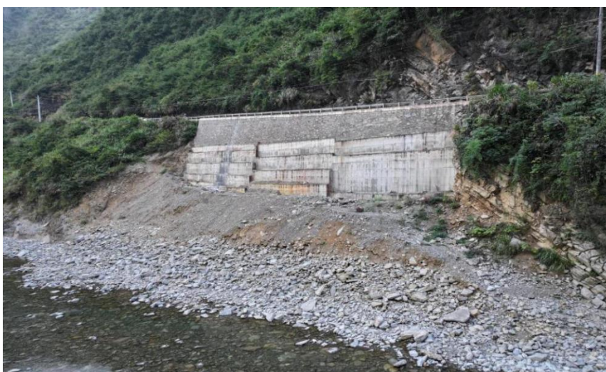
图 3 Y059 城北线 K0+800 路基修复后
