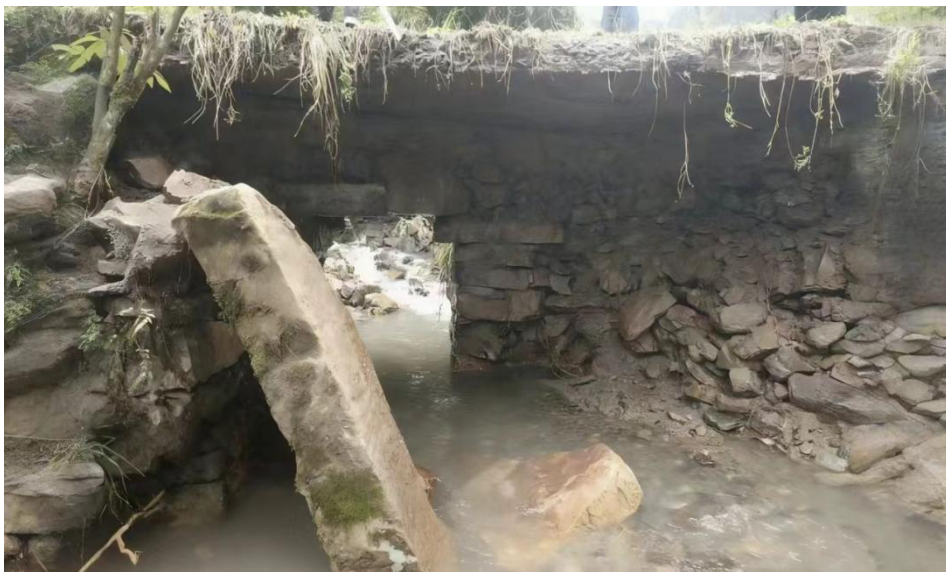
图 1 C905 聂二线涵洞施工前
