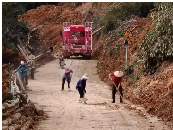
图 15 打通抢险设备进入灾区通道
